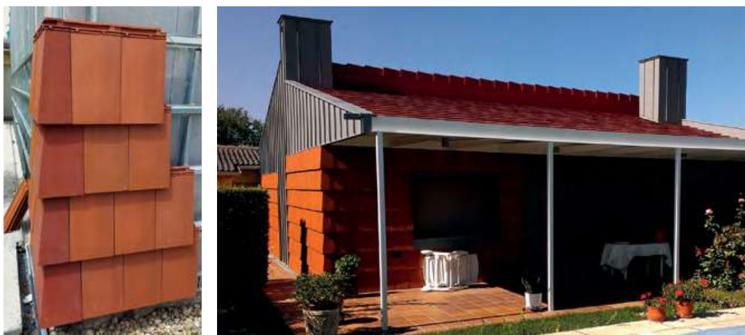
Figura 39. Fachada ventilada de teja cerámica
