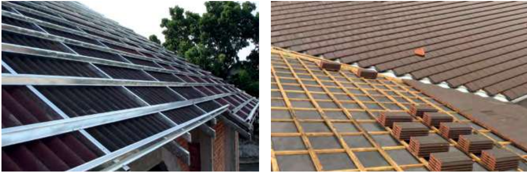
Figura 45. Tipos de rastreles de diferentes materiales
