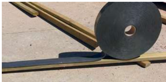
Figura 47. Colocación de cinta adhesiva en listones
