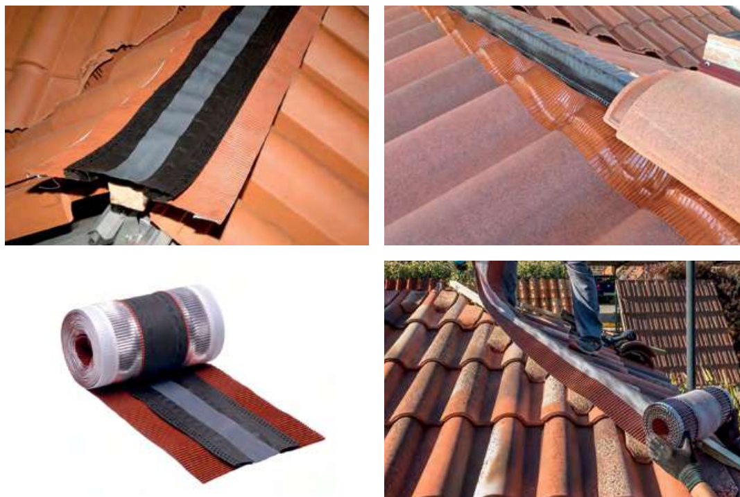
Figura 77. Instalación de bandas impermeables traspirables o microperforadas para conseguir la micro-ventilación en cumbrera y limatesas
