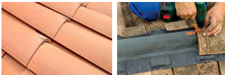
Figura 51. Izda.: Ganchos para la sujeción de tejas curvas (sólo en tejas cobijas) Dcha.: Ganchos de cumbre para la fijación en seco de las piezas de caballete
