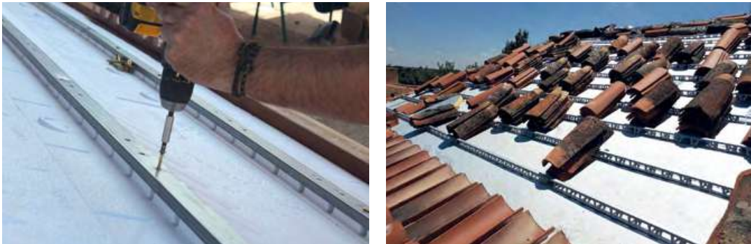
Figura 46. Rastreles simples sobre diferentes soportes continuos
