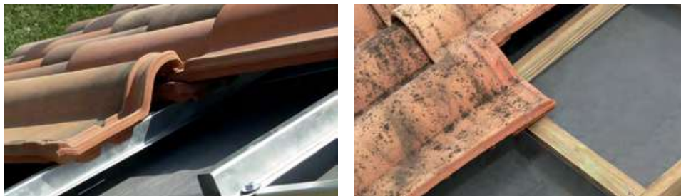
Figura 69. Espacio de circulación de la capa de microventilación de 4 cm por el doble rastrel
