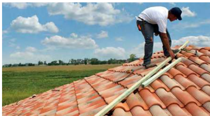
Figura 76. Rastrel de limatesa sobre soporte
